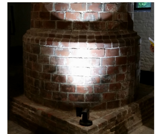
Links: Afb. 3 – Detail fundering op staal (M. Sirag. Jzn, 1923, p. 17)
