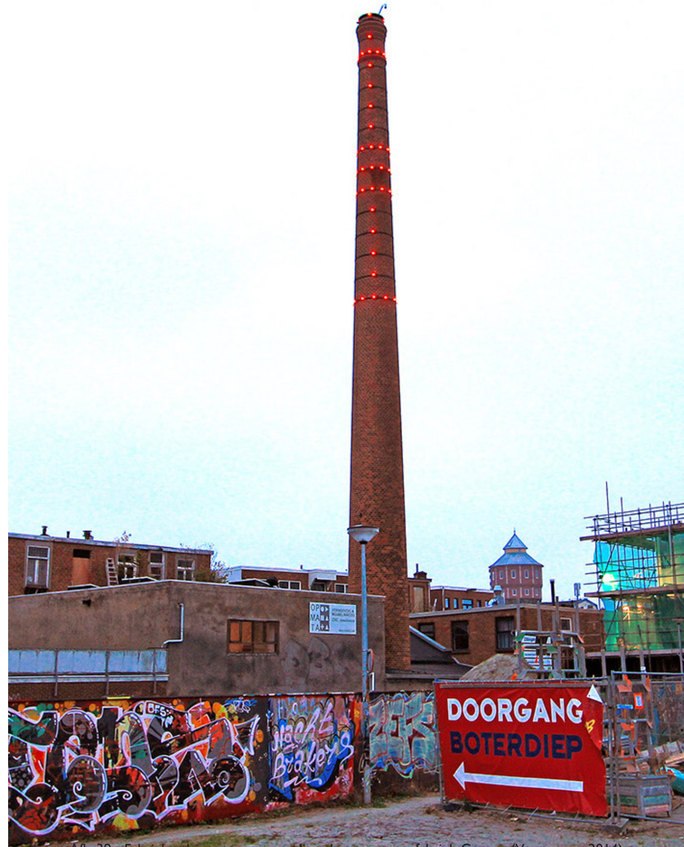
Afb. 39 - Fabrieksschoorsteen voormalige vleesconservenfabriek Gerzon (Verstappen, 2014)
