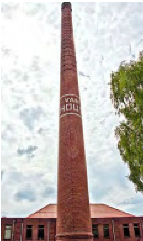
Afb. 42 - Fabrieksschoorsteen te Mill (van Hout et al., september 2013, p. 35)
