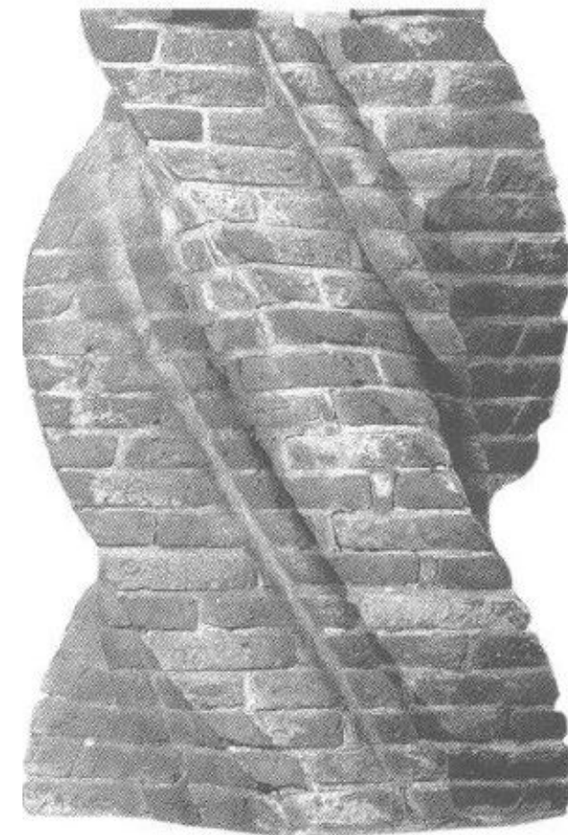
Detail van het rookkanaal, vooraanzicht.
