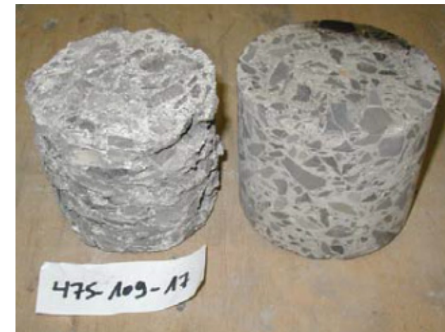
Afb. 6 - Aantasting van beton door zuur (Dieryck & Desmyter, 2004, p. 1)
