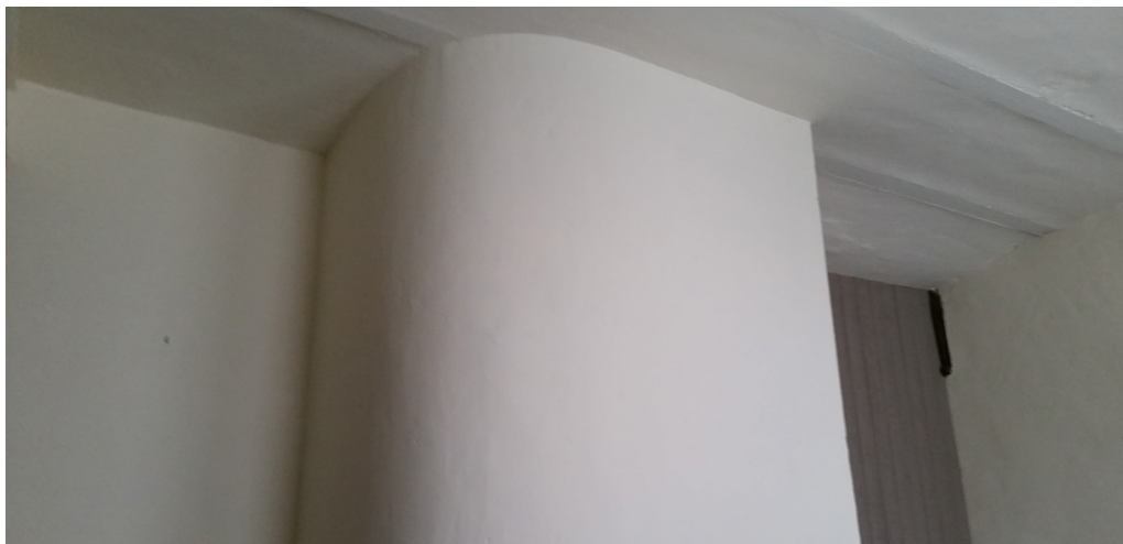
Afb. 49 - Bepleistering schoorsteen burgerhuis te Gingelom (Eigen foto)
