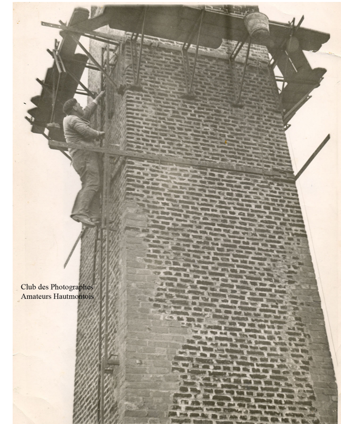
Afb. 11 - Herstelling fabrieksschoorsteen door Jef Toppets, Fotoclub Hautmont (1950)
